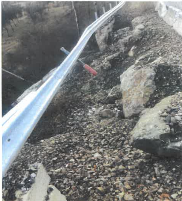
6. Taluz aval- consolidare
