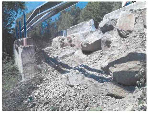
6. Taluz aval- consolidare
