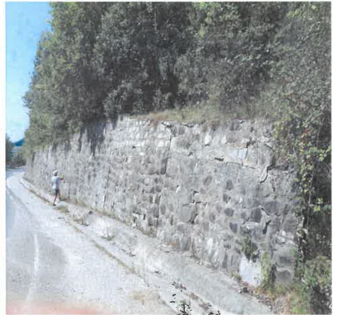
1. Zid de sprijin amonte- reparatie
