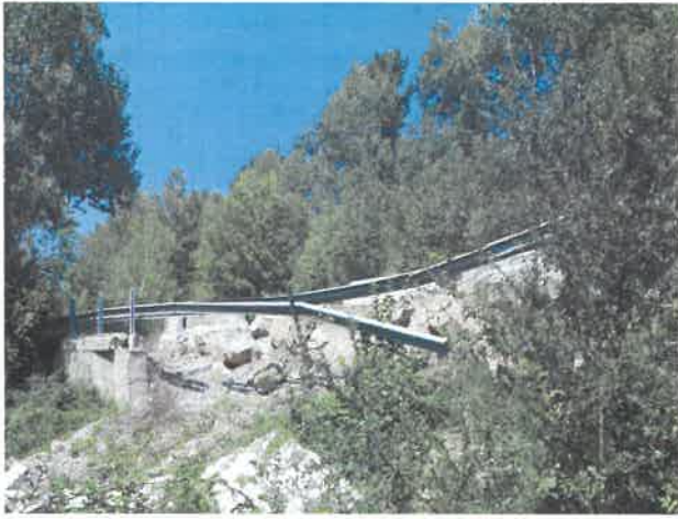
6. Taluz aval- consolidare
